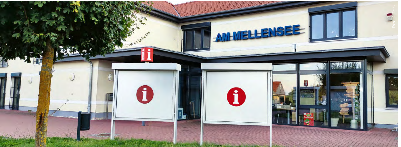
Verwaltungsgebäude der Gemeinde Am Mellensee in Klausdorf
